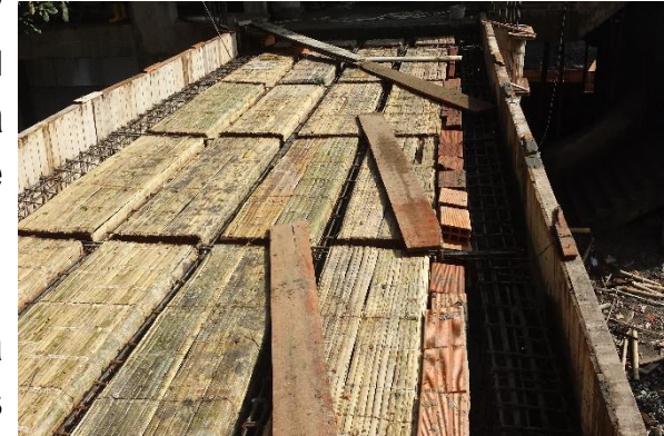
Proceso constructivo de losa aligerada con casetón de guadua.
