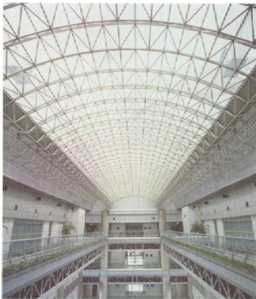
EDIFICIO EMPRESAS PUBLICAS - Medellín / Bóveda Montaje y cálculo: Tecmo-Alco Ltda. - 1998
