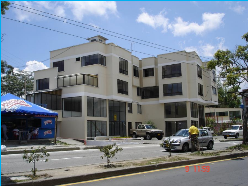
Retroceso excesivo en las esquinas
